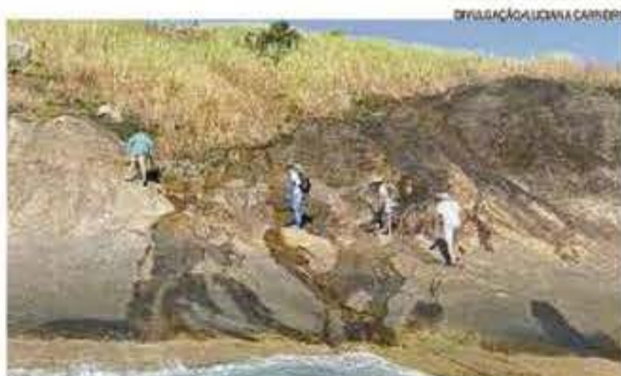
Inspeção. Técnicos visitam a Ilha da Menina, hoje tomada por capim-colônião
